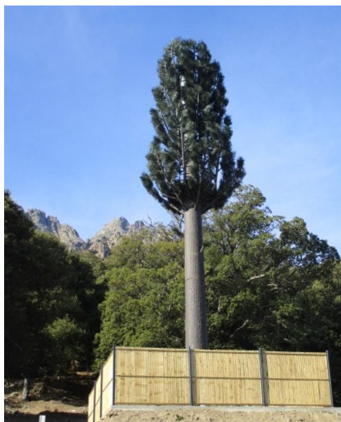
Pylône monotube faux arbre d'U Pulasca
