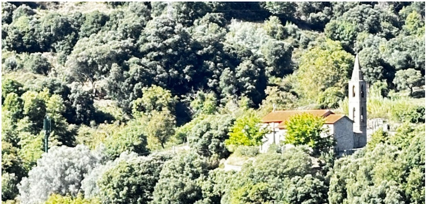
Pylône monotube de Guargale dans son environnement
