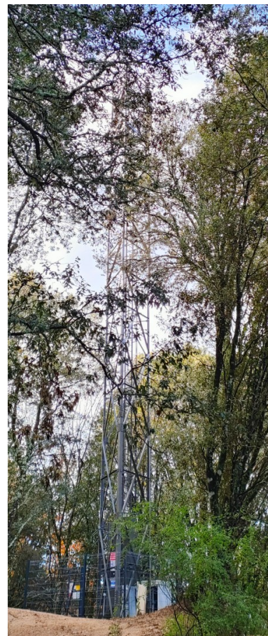
Pylône treillis d'Azilonu
