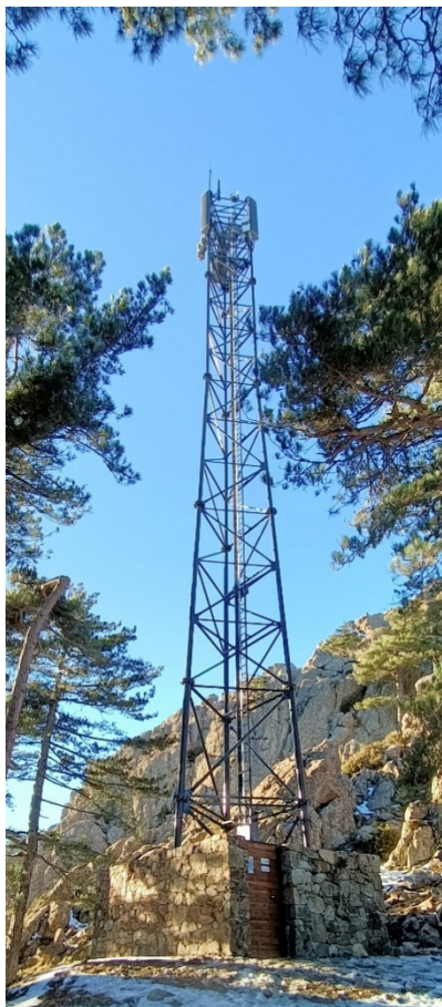
Pylône treillis de Quenza (Bavella)
