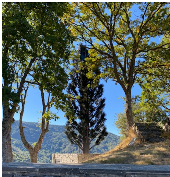
Pylône monotube faux arbre de Monte
