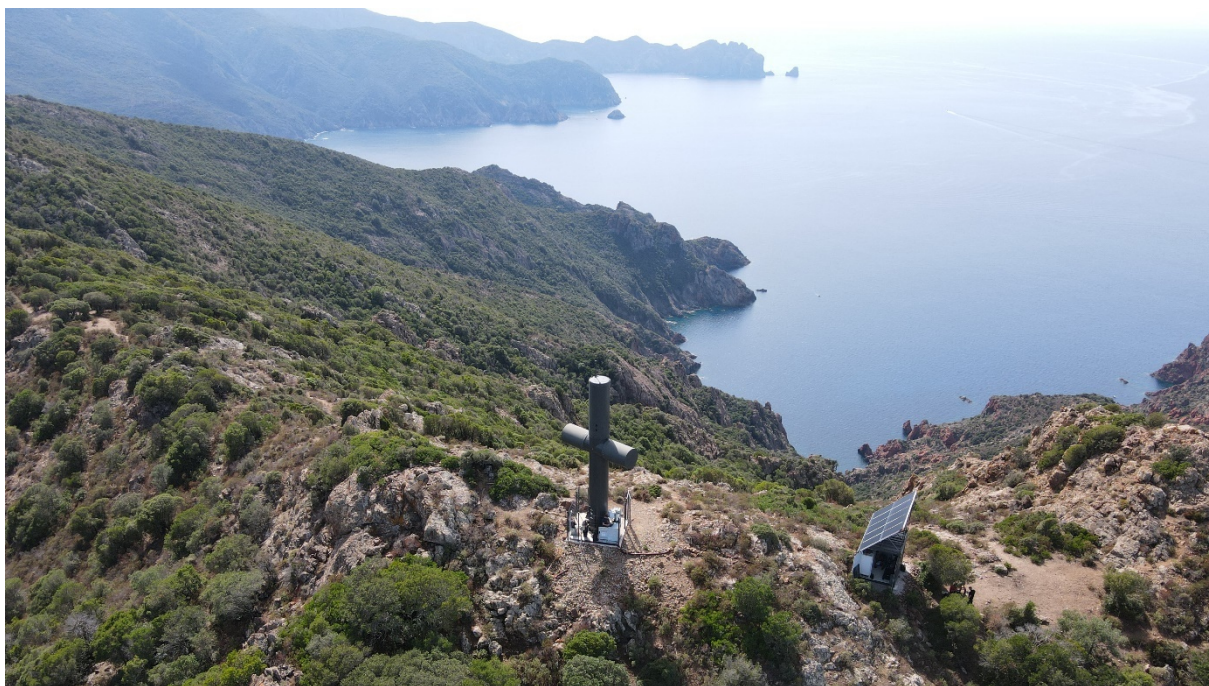
Pylône monotube croix de Galeria (Punta Muvrareccia)
